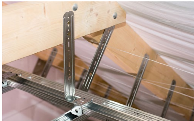
Nowy wymiar wieszaka – długość 350 mm, daje możliwość montażu grubszej warstwy wełny niż dotychczas
