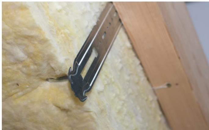
Zaczep do wełny to rozwiązanie, które ułatwia pracę wykonawcy podczas montażu termoizolacji
